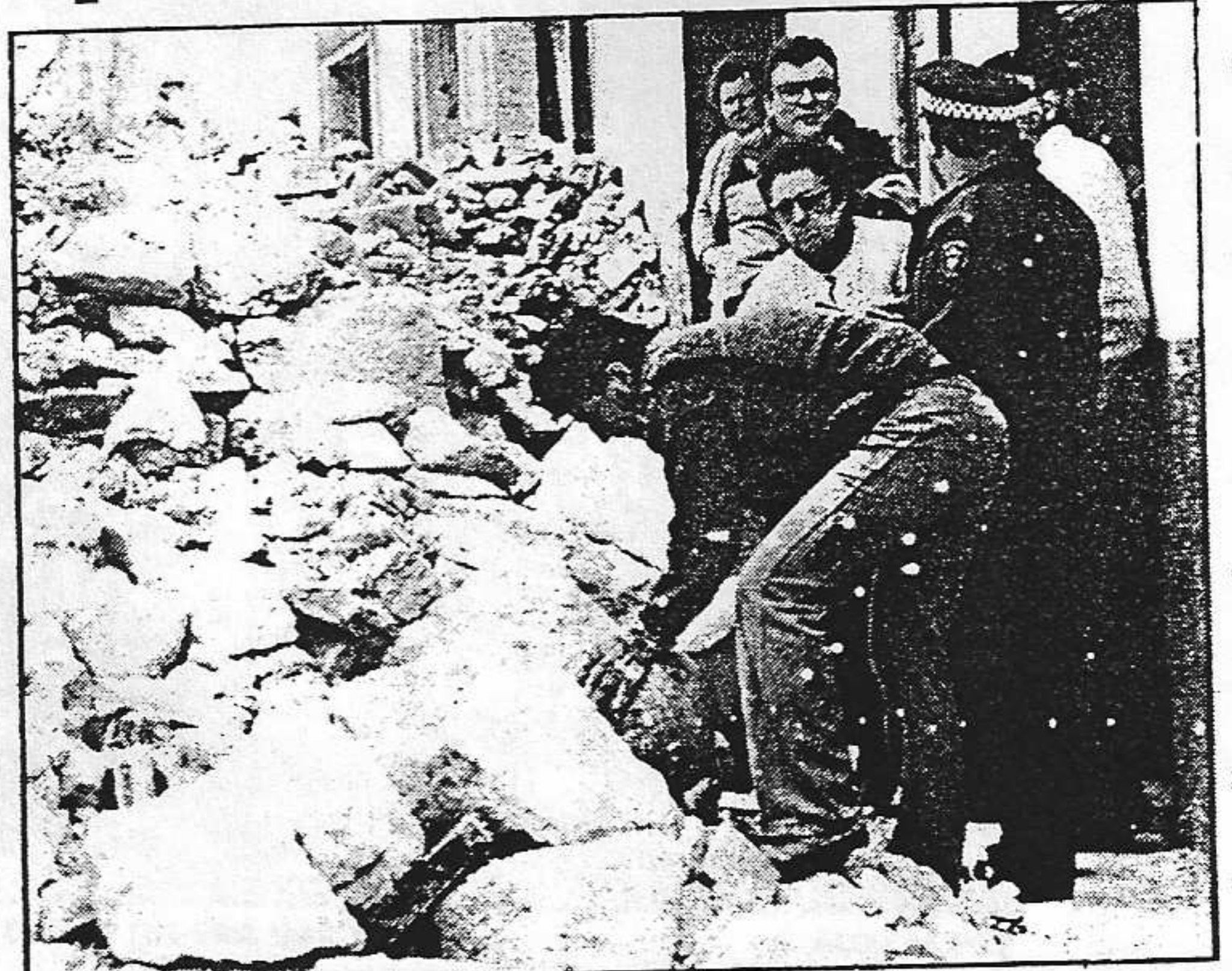
Las puertas de varias casas quedaron tapiadas.
