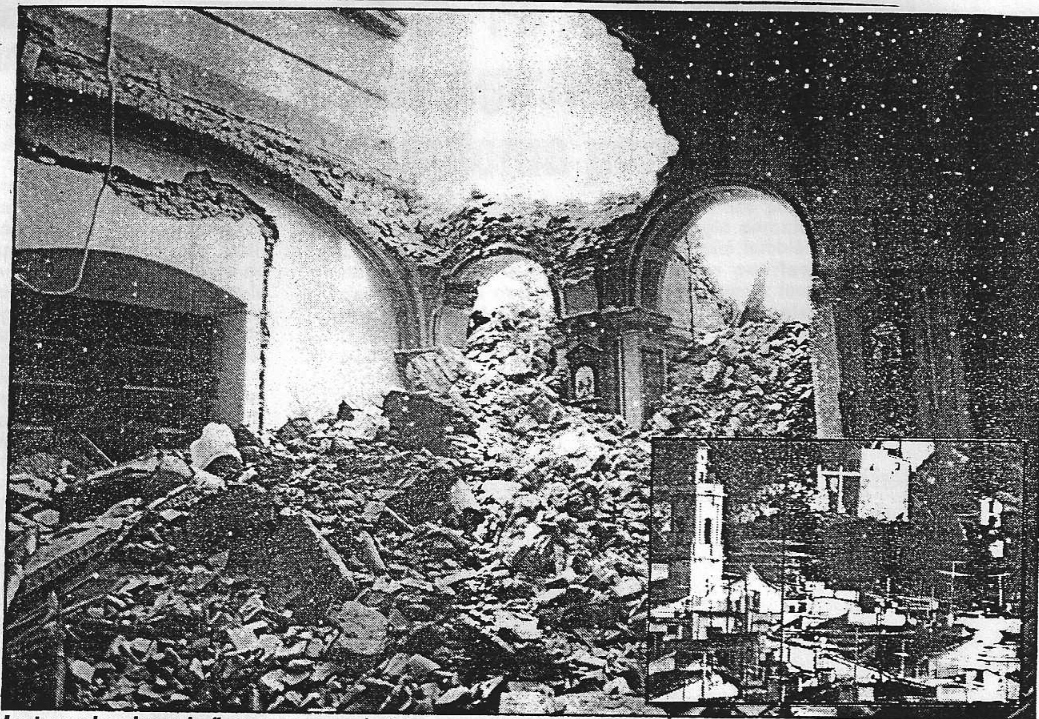
La torre desplomada (la que se ve en la foto pequeña) causó graves destrozos.
